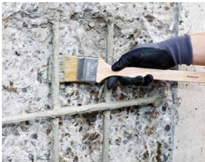
Påføring av MasterEmaco P 5000 AP på rengjort armering
