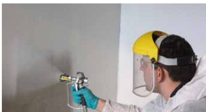
Påføring med sprøyte av MasterProtect 330 EL som rissoverbyggende karbonatiseringshemmende beskyttelse av vegg i parkeringsanlegg.
