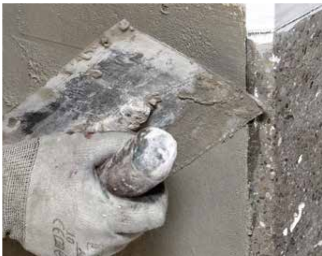
Avretting av overflate med MasterEmaco N 5100 FC
